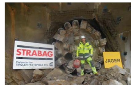
Trigonos war auch dafür zuständig, dass die Tunnelbohrmaschine beim Bau des 8,6 km langen Druckwasserstollens vom Tuxbach zum Stillup-Speicher ihr Ziel exakt erreichte. Das gemeinsame Kraftwerk „Unterer Tuxbach“ von Verbund und Stadtwerke Schwaz wird noch heuer in Betrieb gehen.
